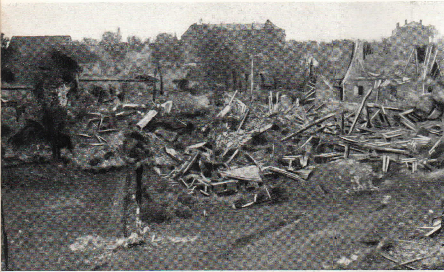
Vue d'ensemble de la menuiserie écrabouillée.
