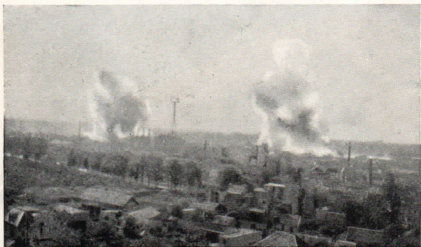
Deux bombes viennent de tomber encadrant l'usine électrique.
